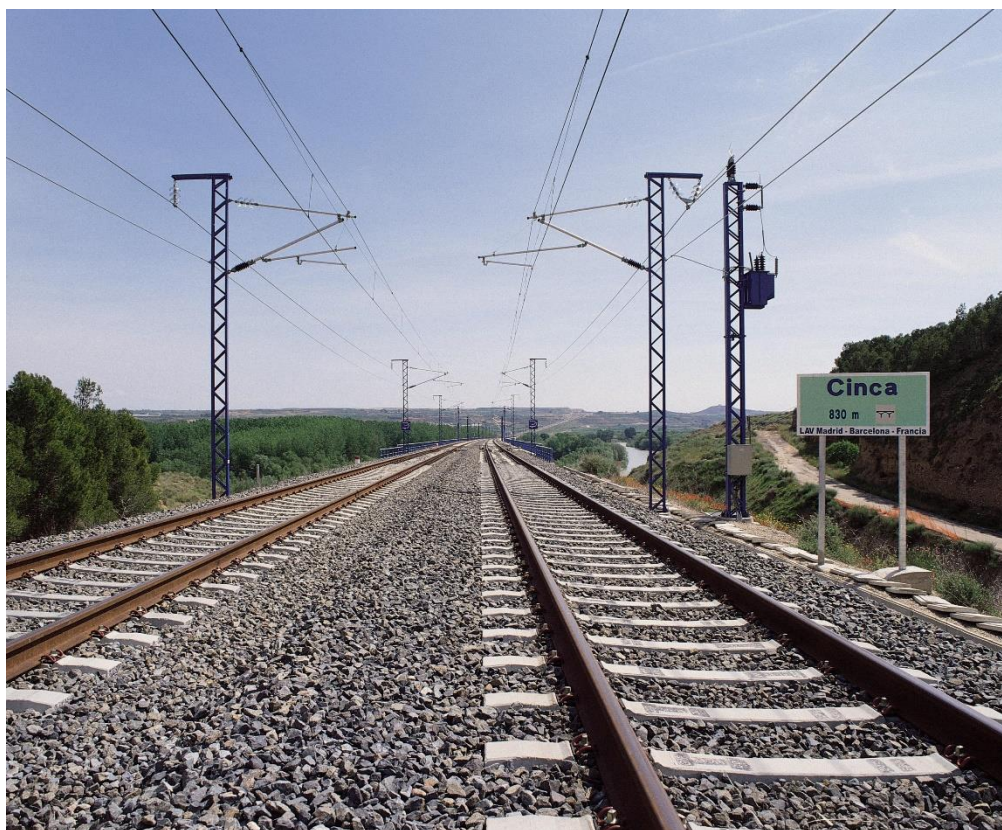
LAV Madrid-Barcelona. Viaducto Cinca
