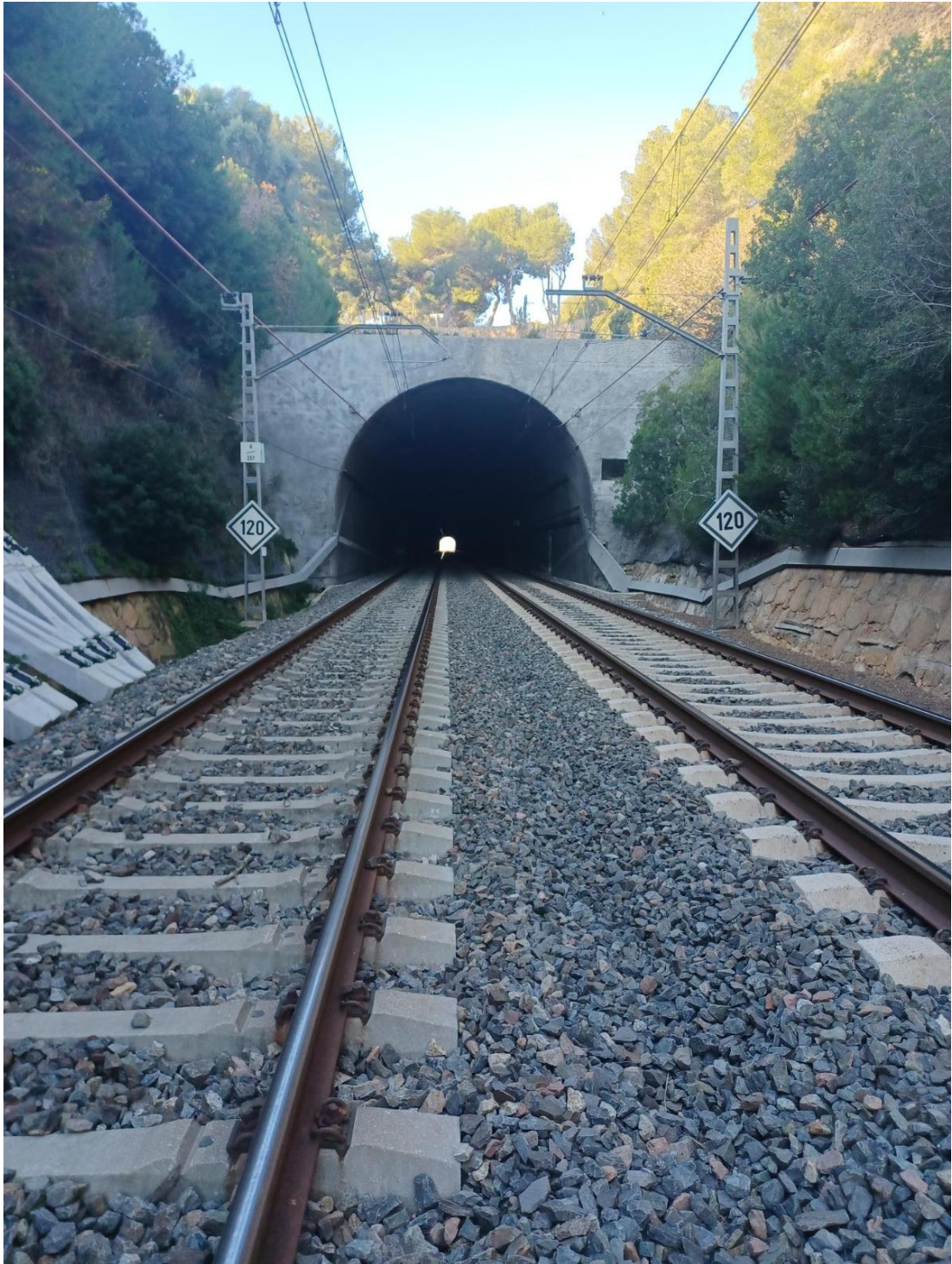
Túnel de Roda de Berà
