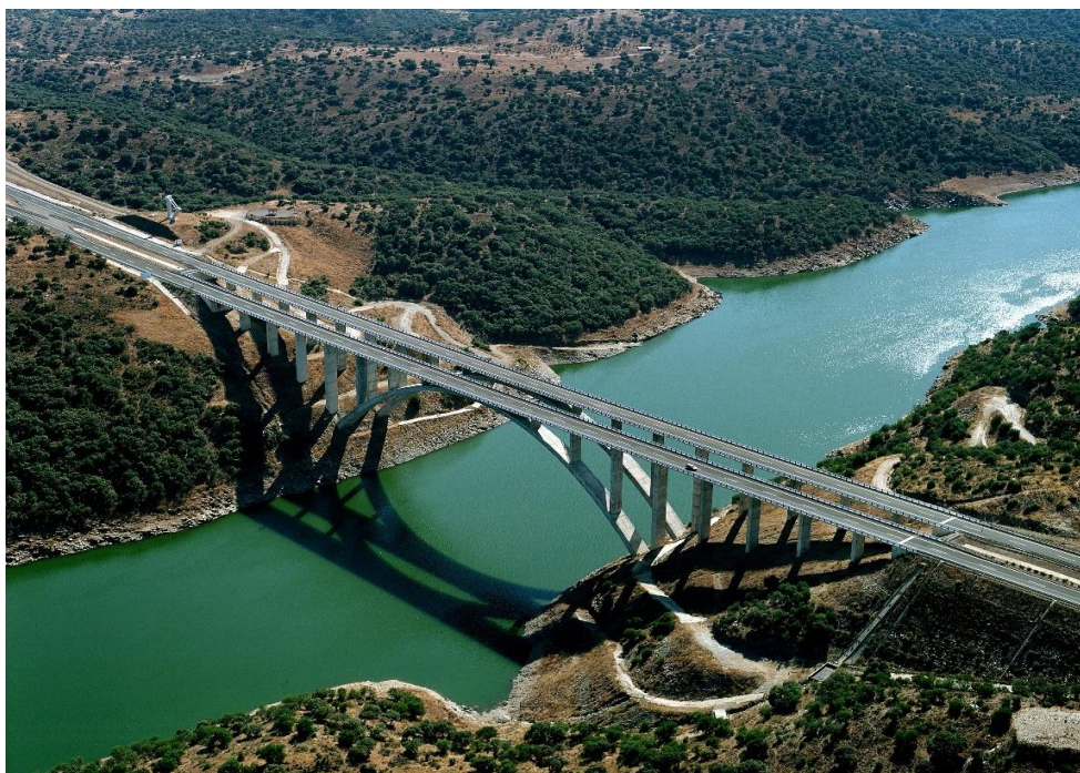
A-66. P.K 532. Puente sobre el Río Almonte
