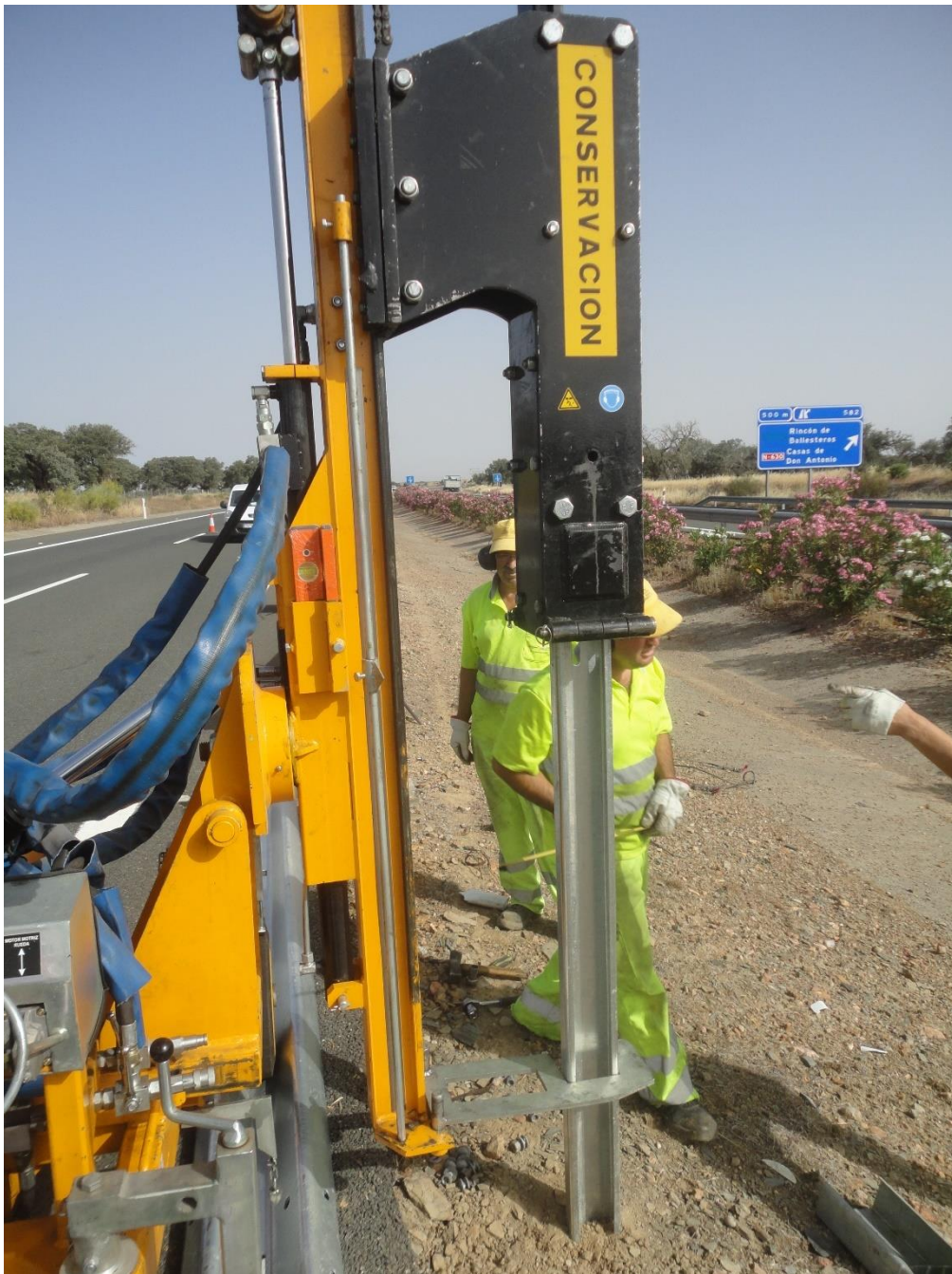
A-66. P.K 585. Colocación de barrera seguridad
