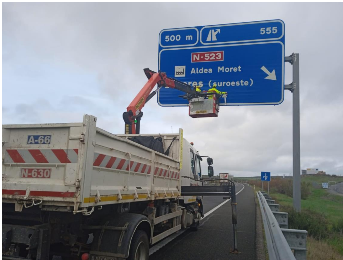
A-66. P.K. 555. Colocación de cartel
