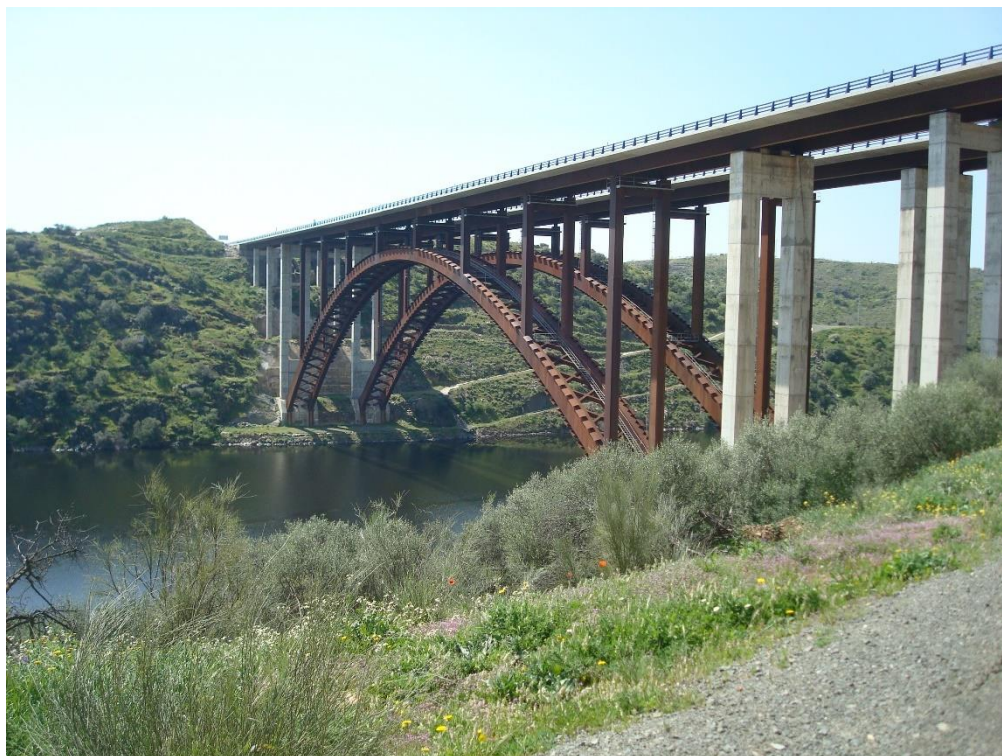
A-66. P.K.520. Viaducto sobre el río Tajo
