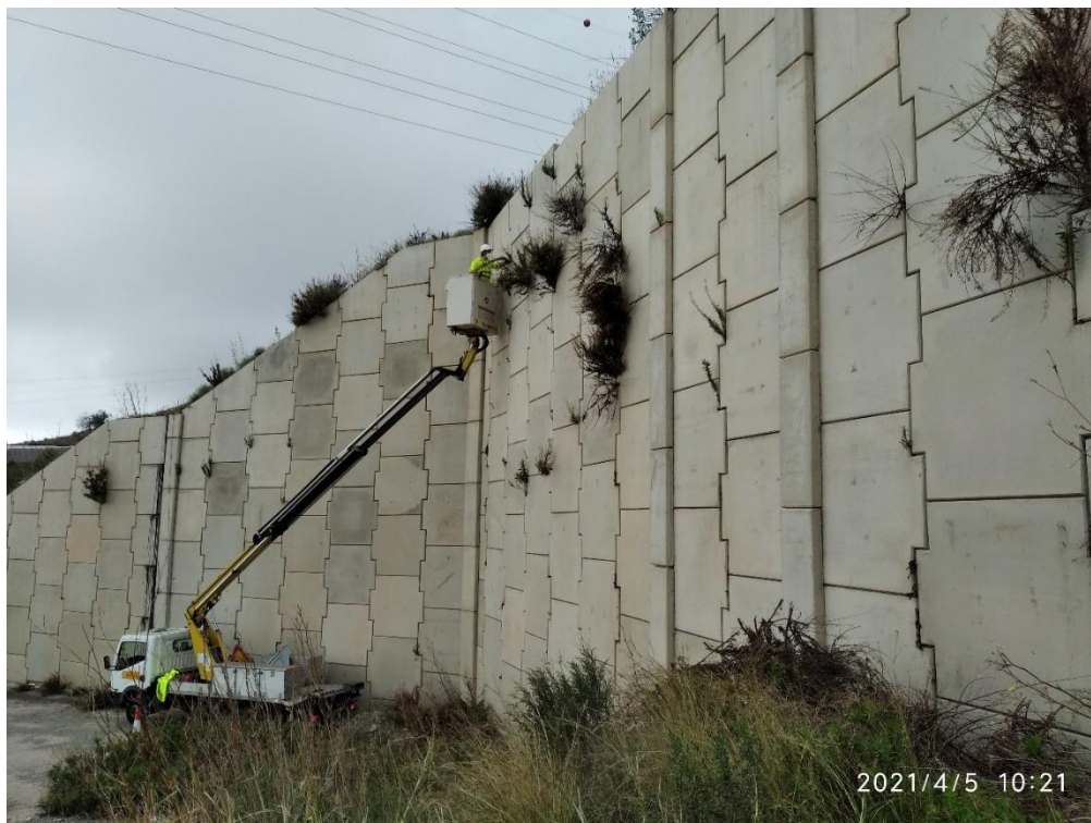
Limpieza de vegetación en muro de tierra armada
