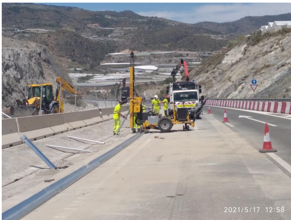
Colocación de barrera metálica
