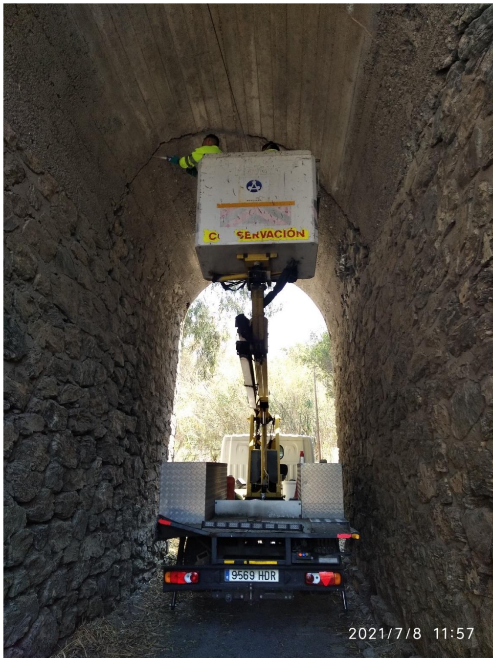
Sellado de grieta
