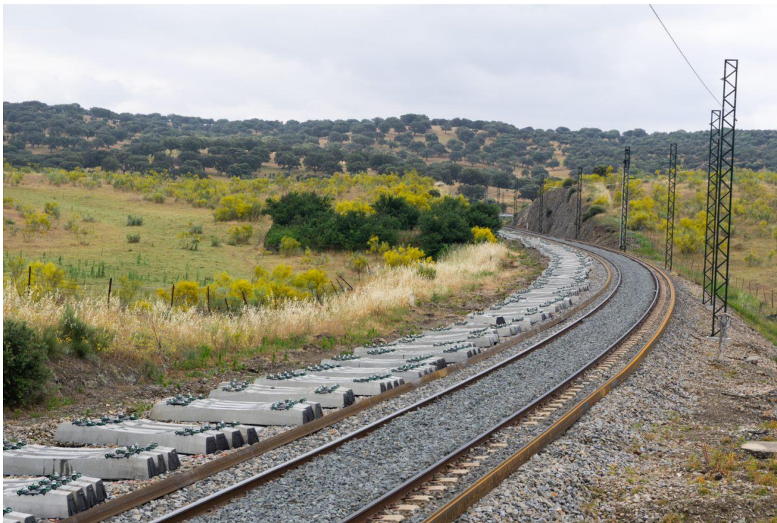
Imagen de obras de renovación de vía.
