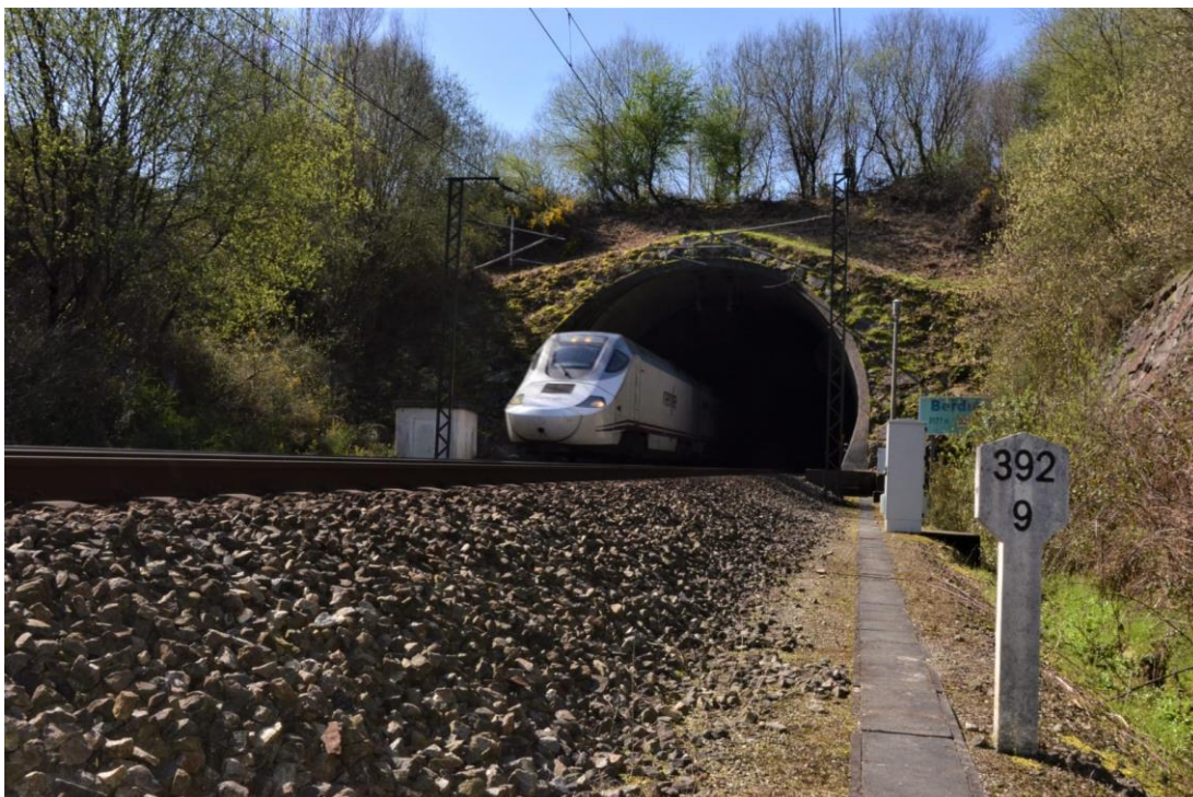
Túnel de Berdía
